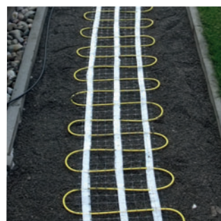
pokládka topné rohože HMO
